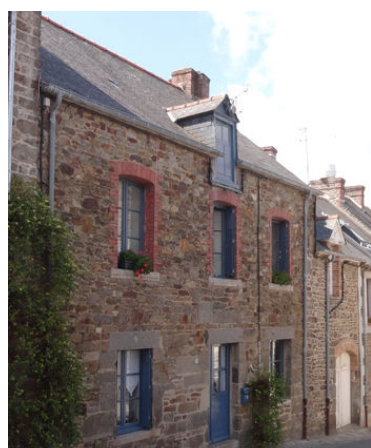
Appareillage différent (pierres ou briques) sur une même construction
