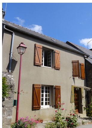
Façade en pierres recouverte par un enduit.
